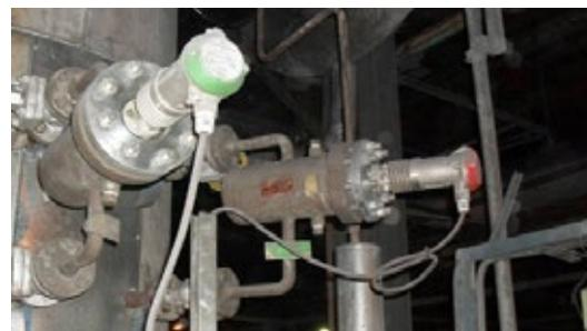
Trimod Besta Schwimmerkammer Typ: I021-1C0RC1
