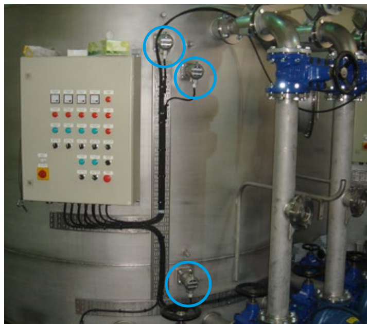
Füllstandschalter Typ: A 01 051E15
