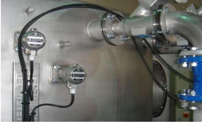
Füllstandschalter Typ: A 01 051E15
