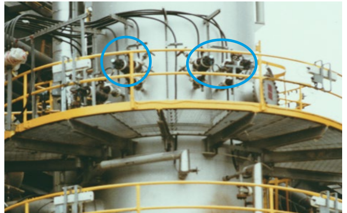
2 Hoch- und 1 Hoch-Hoch-Alarm
